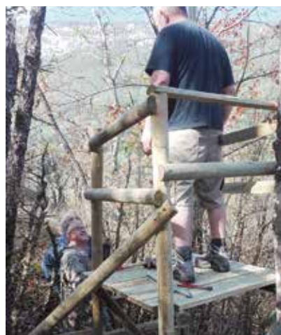
Mise en place d'un mirador
