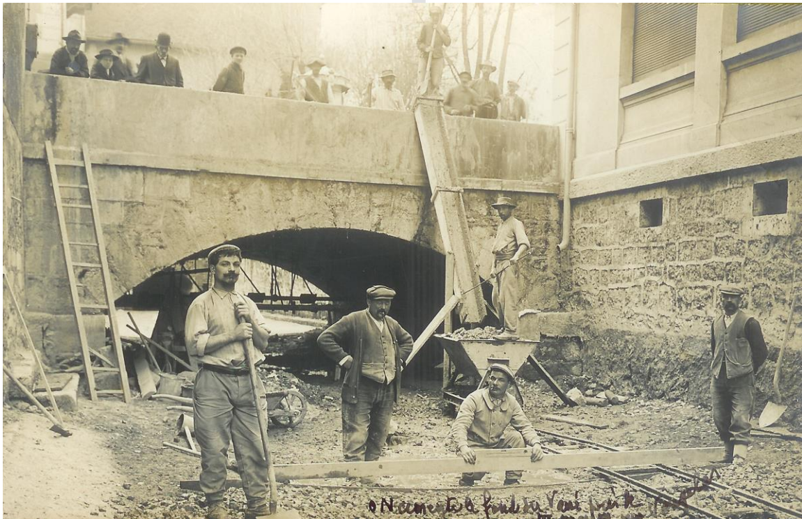
Bétonnage du Vassé, courant du XIX e siècle. Couverture partielle du canal du Vassé. Ces travaux ont donné naissance à la place de la Libération. Crédit : Archives municipales d'Annecy. Fonds Langlet.
