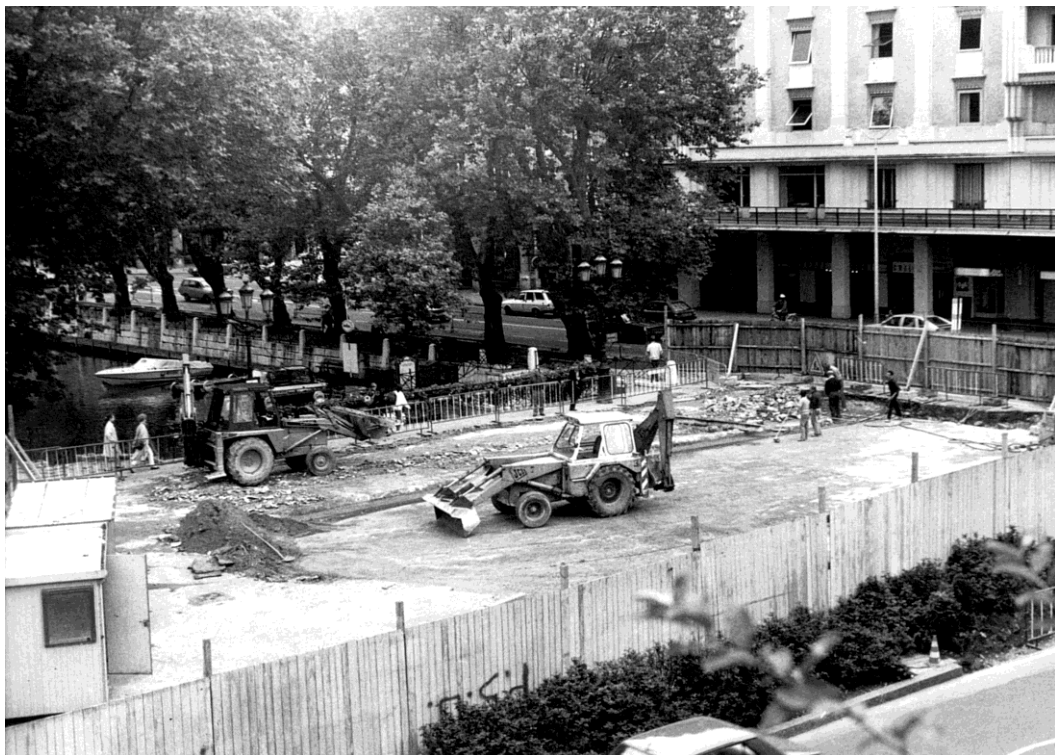
1984. Travaux de rénovation du Pont, un renforcement du dallage avait été réalisé. Crédit Archives municipales d'Annecy
