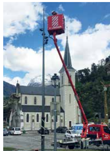
Remise à neuf de l'éclairage
