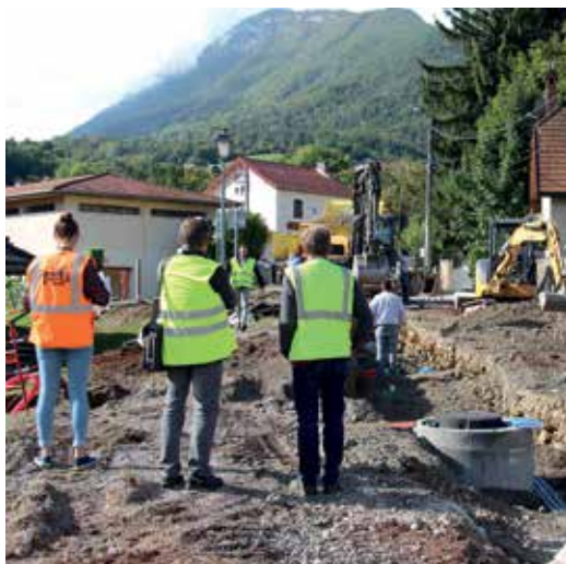
Travaux rue des Prés Bernard
