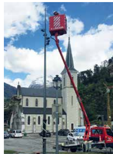
Remise à neuf de l'éclairage
