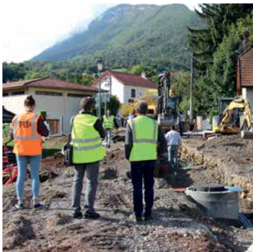
Travaux rue des Prés Bernard
