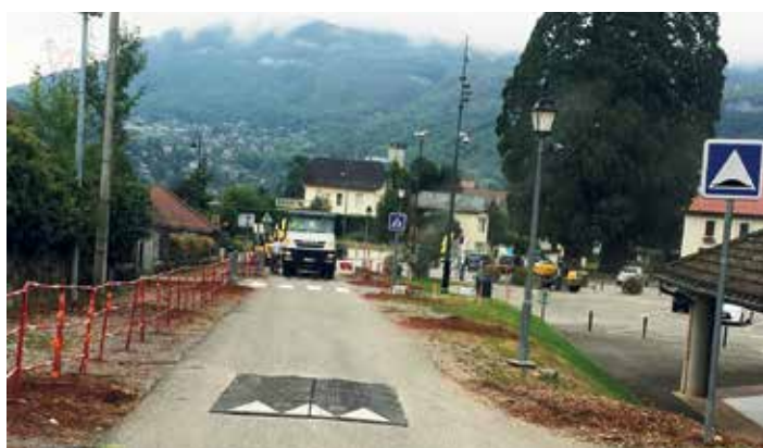
Aménagement de l'entrée de l'école
